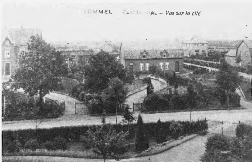
29. Zicht op de arbeiderswijk van Lommel-Werkplaatsen met vooraan links een woning voor een beambte en rechts een dubbele woning voor arbeiders.
